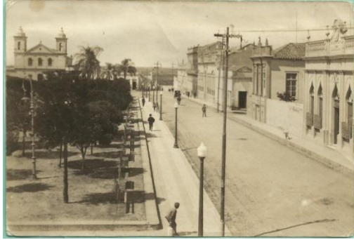
Fig.11: La iluminación de la calle de hierro fundido del paseo en la plaza AM, 1930. Archivo IHGJ.
